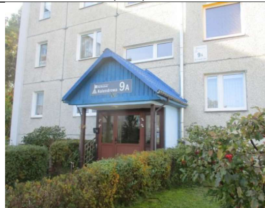
Obiekt wyceny- wejście do budynku
